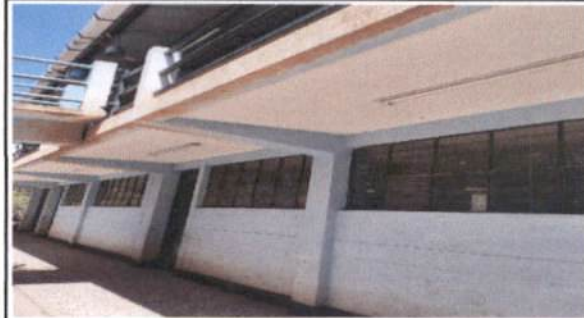
Foto 6: Pintura en muros, interiores y exteriores
