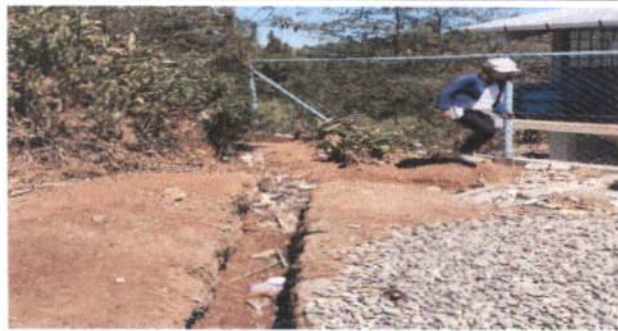
Foto 5: Reparación de bajadas de agua pluvial, tubo y caja de registro
