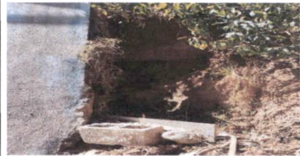
Foto 4: Reparación demuro de Contención.
