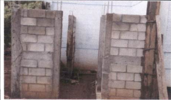
Foto 2: Sustitución de piso o torta de concreto
