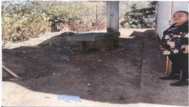
Foto 3: Reparación de planchas de concreto de patio.
